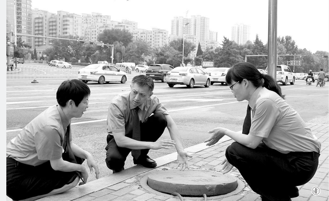
图①：进入8月，山东省济南市莱芜区正值汛期，城区内陆续出现井盖损坏、缺失等问题，为推动最高检“四号检察建议”落地落实，莱芜区检察院积极开展对窨井盖问题的分析调研，加强外部联络，积极与住建、电力、供水、排水等涉窨井盖管理的相关部门取得联系，形成落实整改合力。
